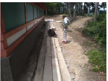
本殿裏参道・新玉垣基礎・石畳新設工事
